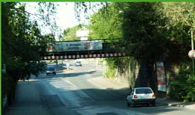
Bahnbrücke über den Bertold-Beitz-Boulevard parallel zur Gladbecker Straße
